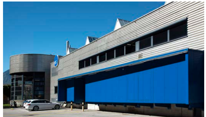
Centrale dei Servizi Industriali
