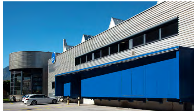
Centrale dei Servizi Industriali
